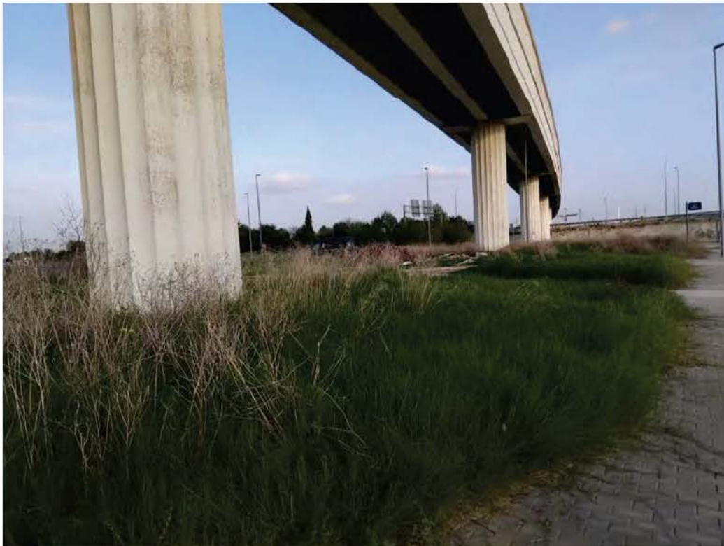
Ilustración 13. Punto 10 del recorrido fotográfico
