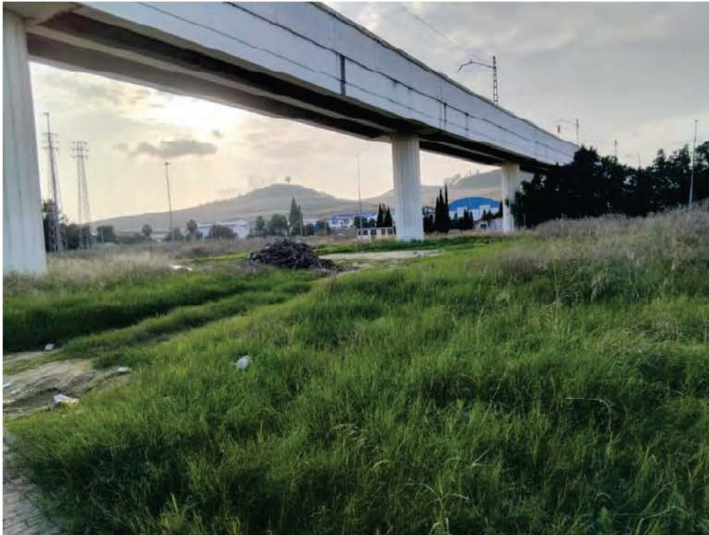
Ilustración 8. Punto 5 del recorrido fotográfico
