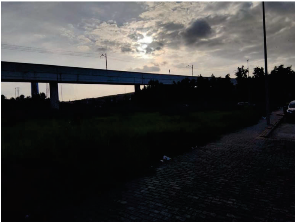
Ilustración 7. Punto 4 del recorrido fotográfico
