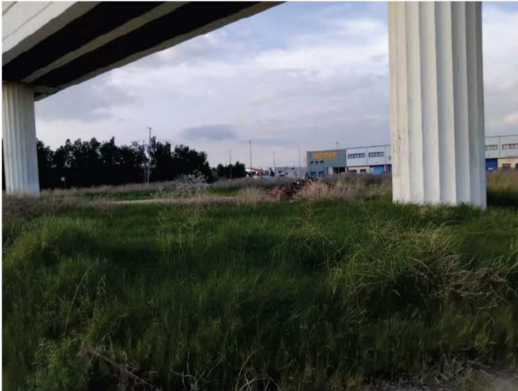
Ilustración 12. Punto 9 del recorrido fotográfico
