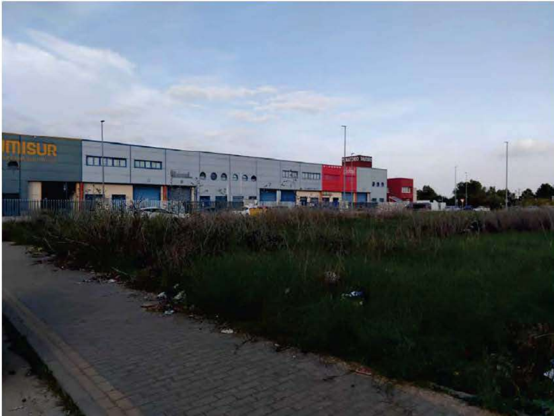
Ilustración 16. Punto 13 del recorrido fotográfico
