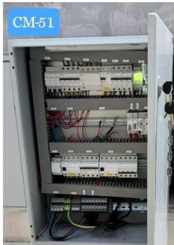
CMP51 - Adecuación insitu manteniendo envolvente. Aparamenta y repaso de tierra
