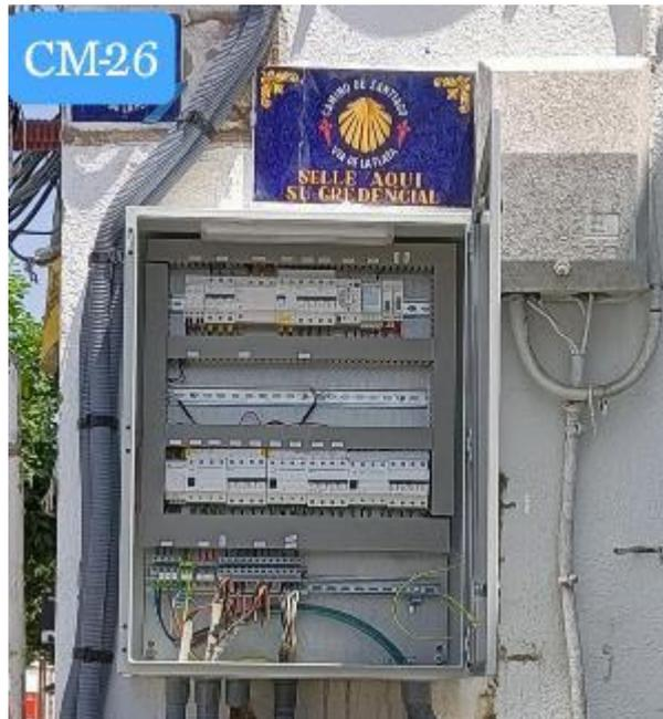
**CMP26-** Renovación completa de envolvente y aparamenta
