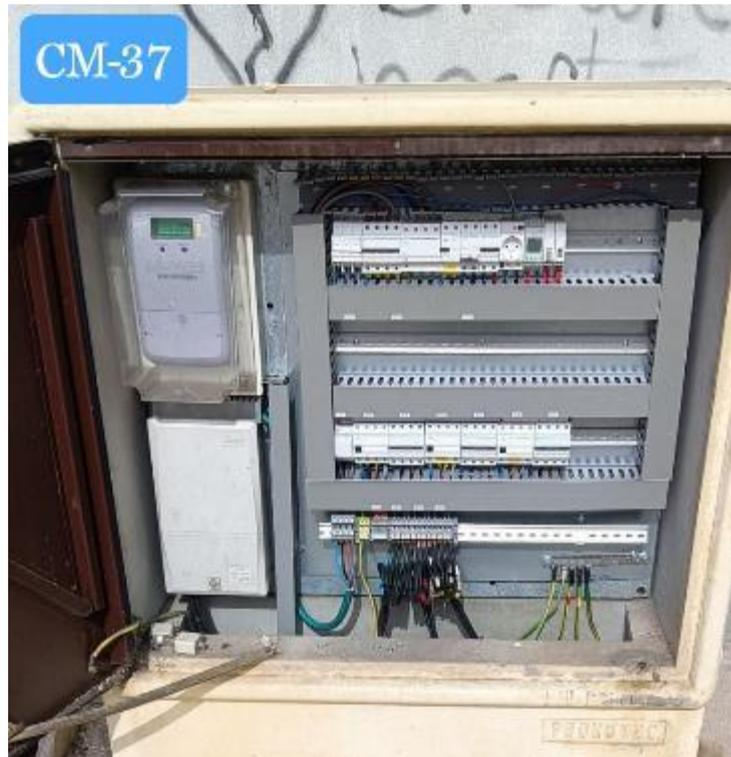
CMP37 - Adecuación insitu manteniendo envoltente de hormigón. Aparamenta y repaso de tierra
