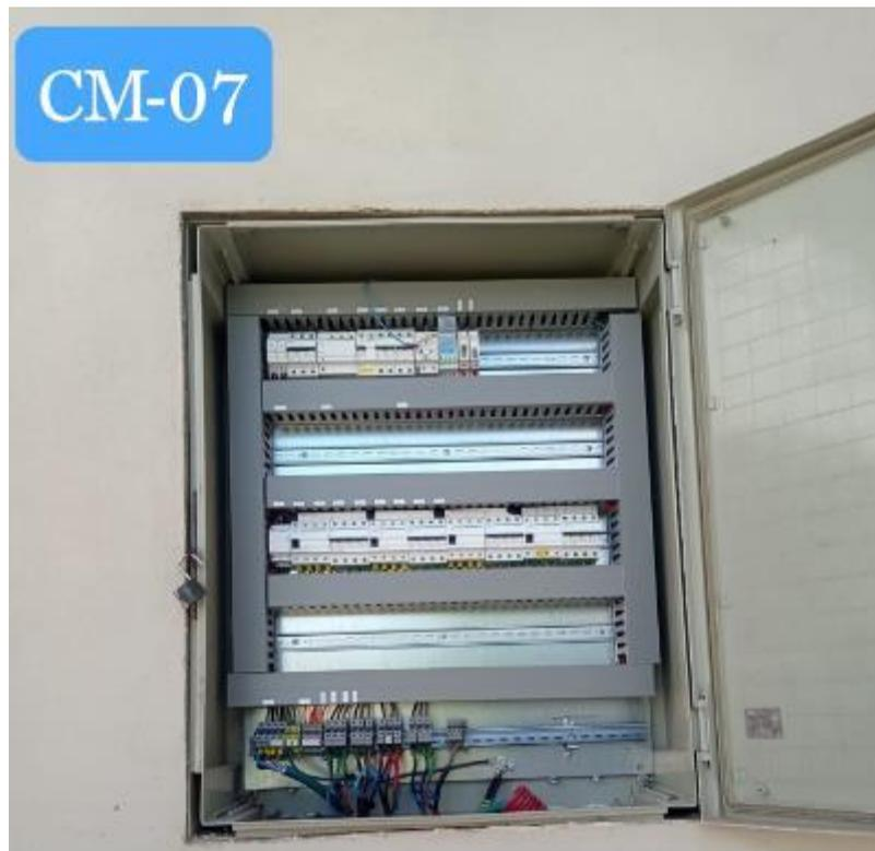
**CMP07 -** Renovación de cuadro incluyendo adecuación con trabajos de albañilería para mantener ubicación
