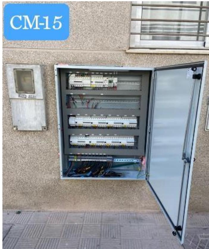
CMP15 - Renovación de cuadro incluyendo adecuación con trabajos de albañilería para mantener ubicación
