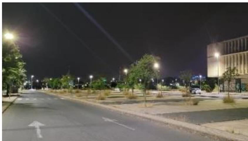
Actuación en Parque Empresarial Vega del Rey. Luminarias TECEO. Adecuación de canalizaciones, reposición de circuitos de alumbrado, revisión de puestas a tierra y condenado de arquetas
